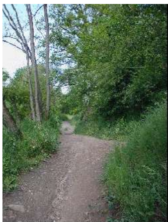
Obr. 5. Cyklostezka – úsek SO – 06 (původní stav)
